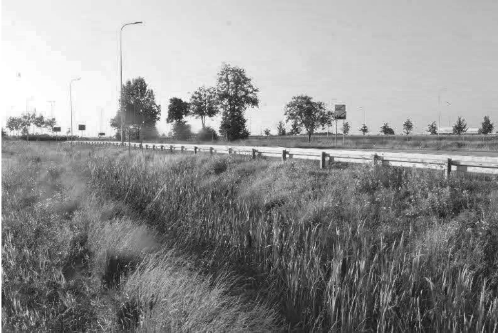
Fot. 6 Rów między terenem planowanego przedsięwzięcia a „starą S7”
