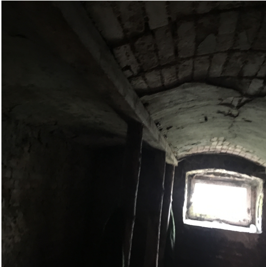
Fot. 7 - Podparcie belek o konstrukcji drewnianej
