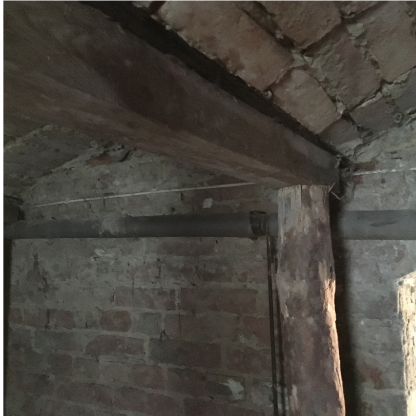
Fot. 9 - Podparcie belek o konstrukcji drewnianej
