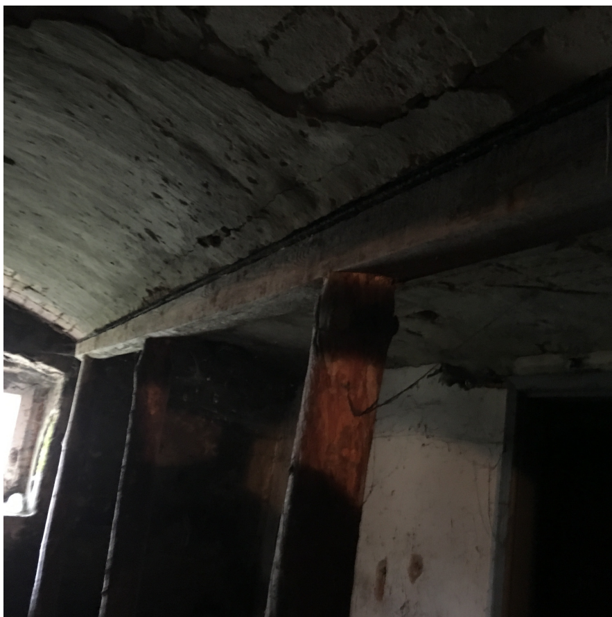
Fot. 8 - Podparcie belek o konstrukcji drewnianej
