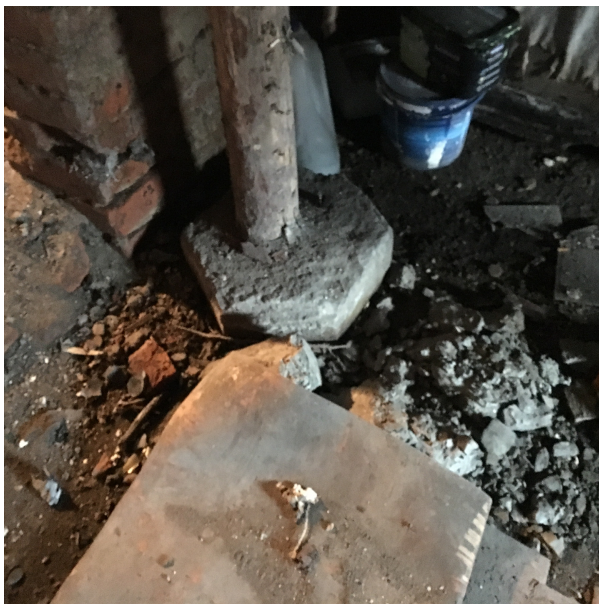
Fot. 11 - Podparcie belek o konstrukcji drewnianej
