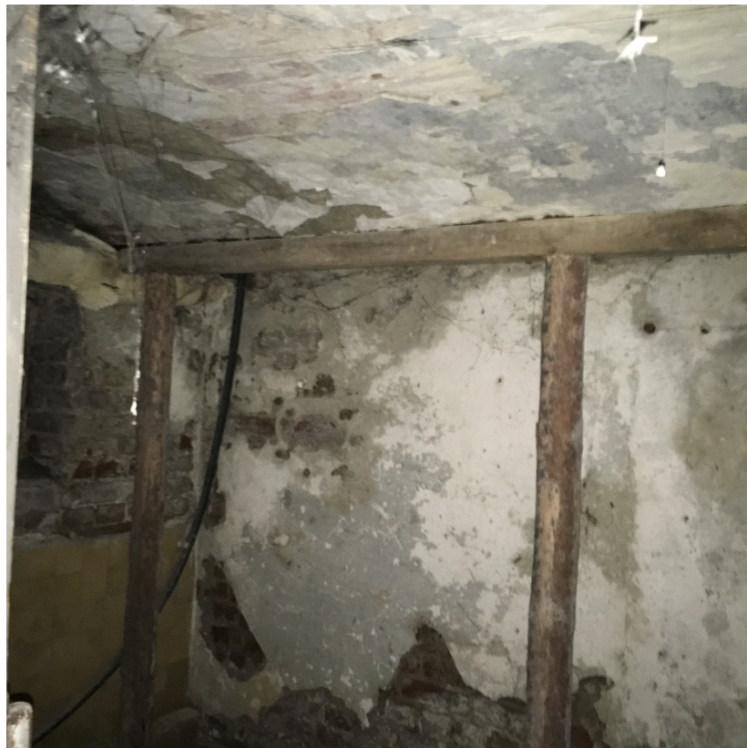
Fot. 10 - Podparcie belek o konstrukcji drewnianej
