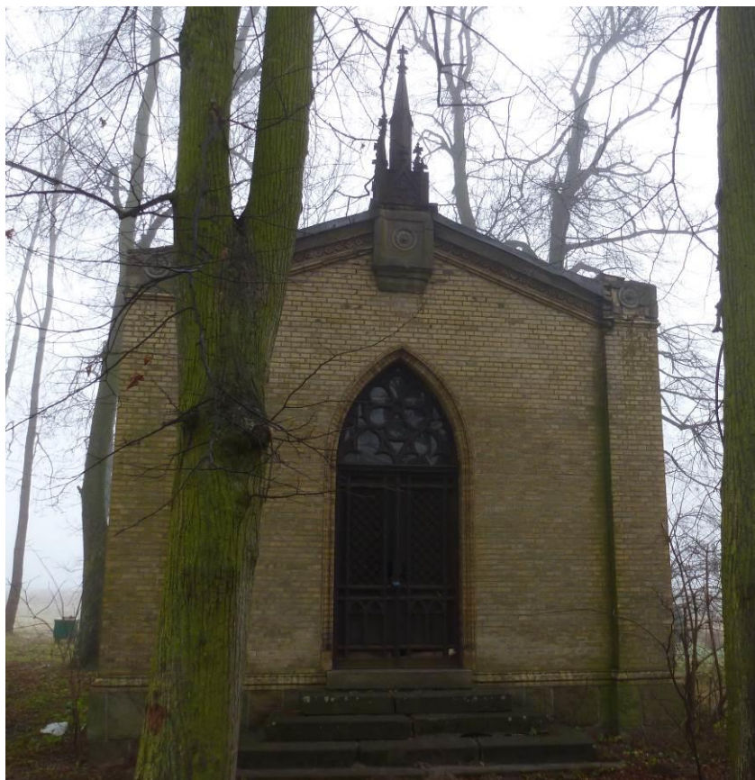
1. Elewacja frontowa zachodnia
