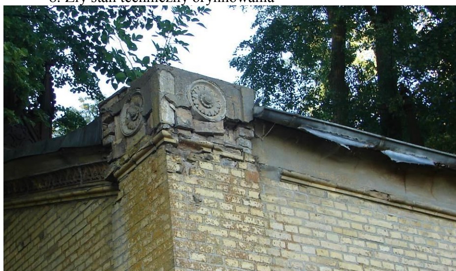
9. Uszkodzenia głowicy pilastra, brak fryzu ceramicznego - elewacja południowa
