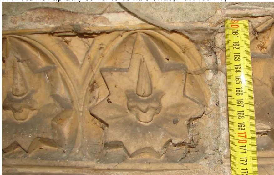
12. Kształtka ceramiczna fryzu podokapowego
