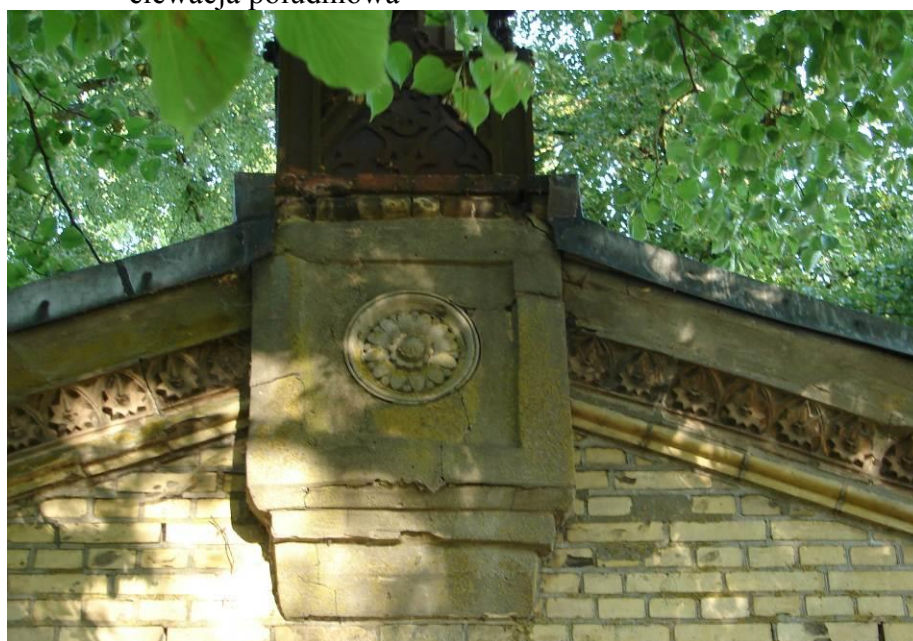
9. Uszkodzenia głowicy pilastra, brak fryzu ceramicznego - elewacja południowa
