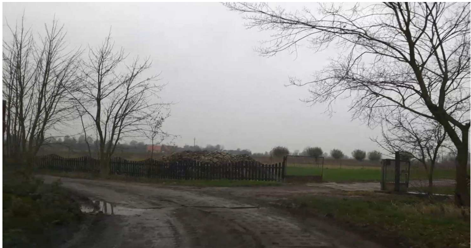
Zdj.8: Dodatkowy, środkowy rząd płyt na zakręcie na odcinku 2.
