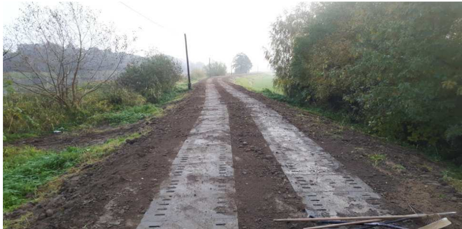
Zdj.13. Przykładowa realizacja drogi z analogicznych płyt ażurowych.
