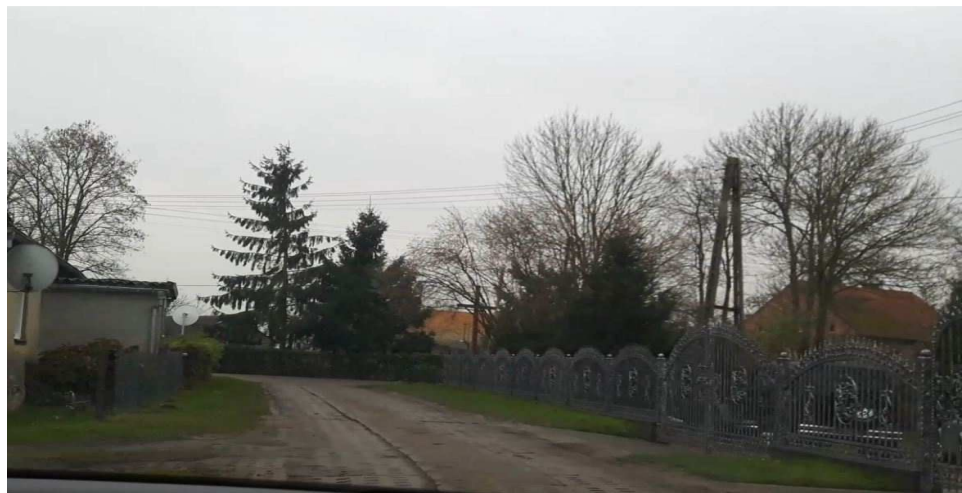
Zdj.5: Początek odcinka 2 o dł. ok. 1,104km na połączeniu z drogą gminną.
