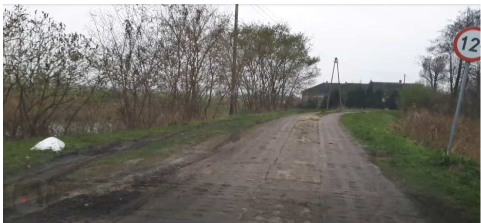
Zdj.1: Początek odcinka 1 o dł. ok. 2,866km w okolicach mostu drogowego w Tujsku.
